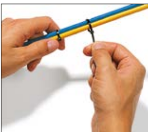
Kabelbinder von Hand vorbündeln.
